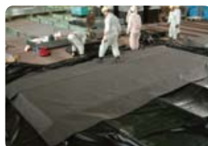
②シート敷設
