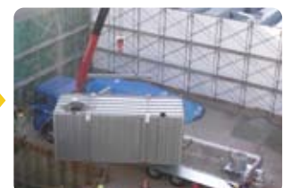
⑧搬入・据付(規格品)
