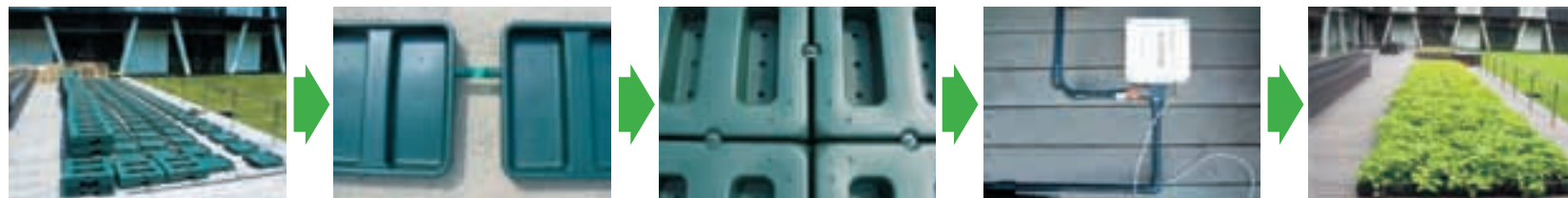
①給水トレイの設置
