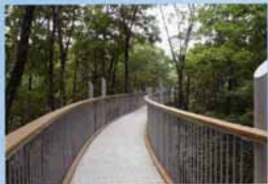
空中回廊 高さ最高9mの空中回廊です。
